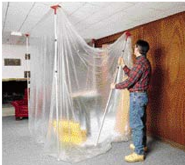
La solution Zipwall permet d'isoler une zone de travaux pour limiter les nuisances.
