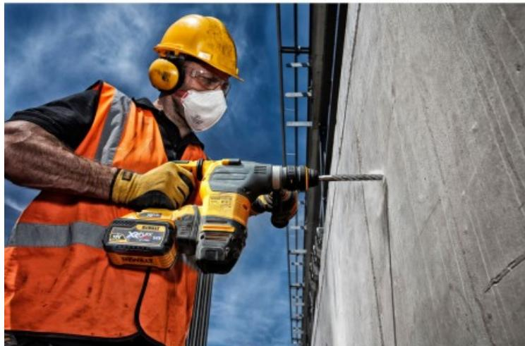
Convient au perçage rapide de trous de vidange, d'ancrage ou dégagement dans des matériaux de maçonnerie, la pierre, le béton et la brique/parpaing
