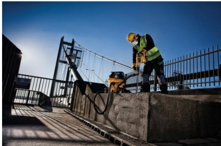
Les forets aspirants DEWALT permettent un perçage sans poussières. Idéal pour des perçages en intérieur, ils permettent de gagner du temps sur les chantiers. Disponible en SDS-Plus et SDS-Max
