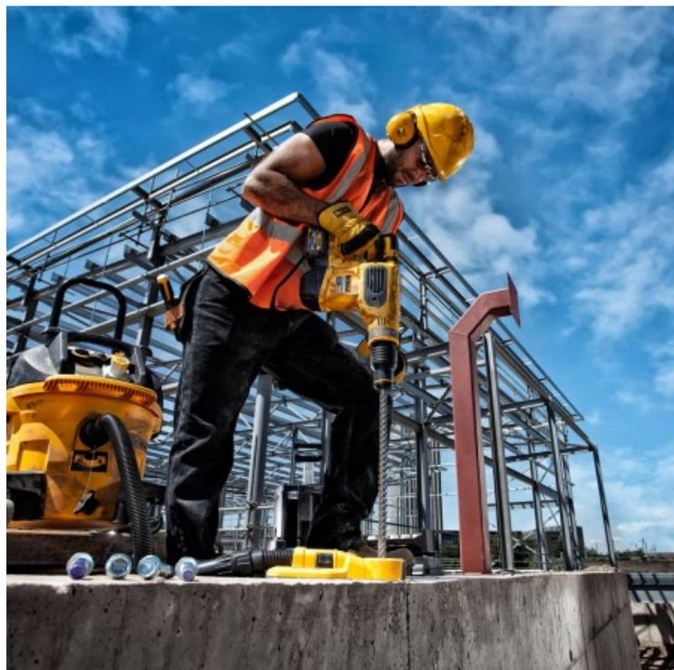
Les forets XLR SDS-Max possèdent une tête en massive en carbure, pour prévenir des cassures et des vibrations. Les quatres hélices permettent une évacuation rapide des débris pour une plus grande efficacité. Perçage dans le béton Garantie 3 ans
